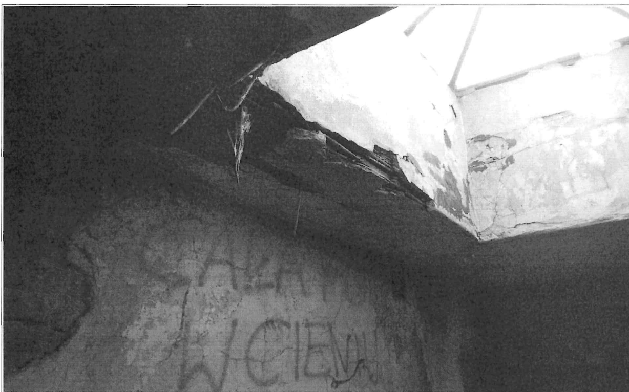
Fot. nr 21,22 – widok stropodachu na klatkę schodową, znaczne zalania sufitów (tynk na trzcinie na deskowaniu), wskutek nieszczelności pokrycia połaci dachu, widoczne są stare jak i nowe zacieki wody opadowej. Należy wykonać w pierwszej kolejności skucie zmurszałych i zawilgoconych tynków z sufitów (możliwość niekontrolowanego odpadnięcia tynków o danej przegrody budowlanej – tynki zmurszałe, odparzone). Po skuciu tynków należy wykonać nowe warstwy wykończeniowe (po remoncie pokrycia dachu – obecnie nieszczelności należy wykonać wymiany deskowania ) tj. suche tynki w postaci podwieszanych sufitów g-k. Całość konstrukcji drewnianej do oczyszczenia, impregnacji, wzmocnienia sprawdzenia, ewentualnie do wymiany na nową z zachowaniem obecnych przekrojów drewnianych. Konstrukcja świetlika dachowego wraz ze szkleniem do wymiany na nową, gdyż stan obecny nie zapewnia bezpieczeństwa użytkowania oraz nie zapewnia izolacyjności cieplnej.
