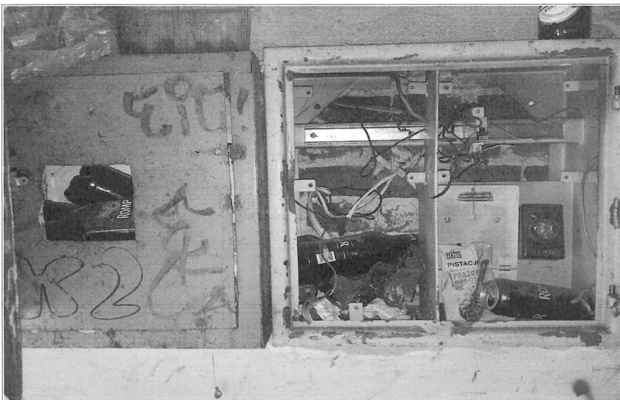
Fot. nr 89,90 – widok kompletnie zdewastowanych i zdekompletowanych rozdzielni elektrycznych, całość resztek instalacji do całkowitego demontażu.
