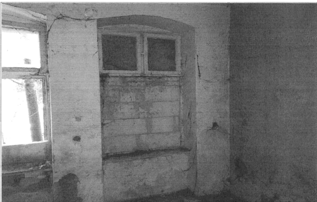
Fot. nr 29,30 – widoczna stolarka stara, drewniane, nie poddawana od lat żadnej bieżącej konserwacji (od zewnątrz widoczne warstwy starej, łuszczącej się farby, stolarka wypaczona, nie domyka się). Okna prowizorycznie zabezpieczone lub zamurowywane od zewnątrz. Całość stolarki drewnianej nadaje się tylko do wymiany na nową, zespoloną z PVC lub drewnianą – wraz systemowymi nawiewnikami powietrza (stolarkę wykonać na wzór istniejącej – tj. podział i wymiary, budynek pod ochroną Miejskiego Konserwatora Zabytków – należy uzgodnić wymianę stolarki z MKZ).
