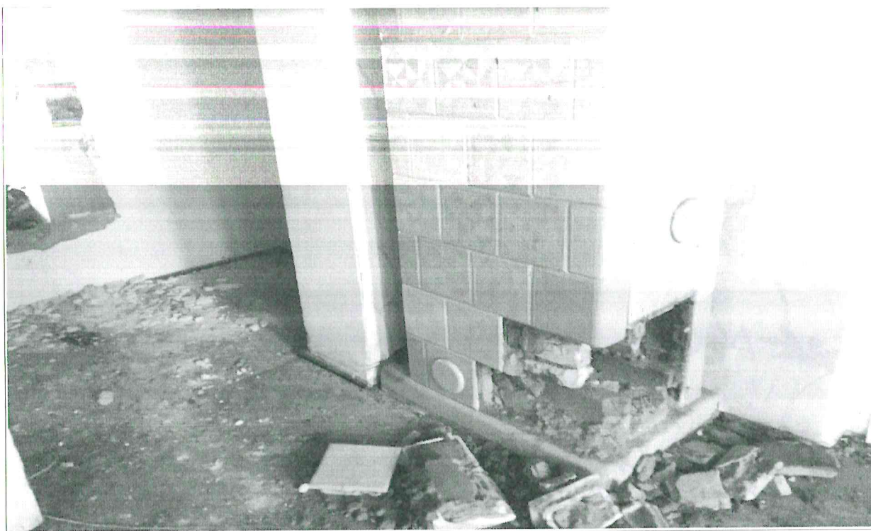
Fot. nr 99,100 – przykładowy widok pieców kaflowych (piece częściowo zdemontowane), obecnie ogrzewanie przy pomocy pieców na paliwo stałe nie zapewnia odpowiednich warunków cieplnych w danych lokalach, lokale nie są prawidłowo dogrzewane, brak odpowiedniej cyrkulacji ogrzewania powietrza w lokalach, zgodnie z wprowadzoną ustawą antysmogową we Wrocławiu piece na paliwo stałe mają być zlikwidowane w ciągu kilku najbliższych lat. Należy dany budynek poddać przyłączeniu do sieci Fortum (ogrzewanie miejskie – wykonanie węzła cieplnego w budynku) lub wykonać ogrzewanie gazowe, indywidualne kotły dwufunkcyjne.
