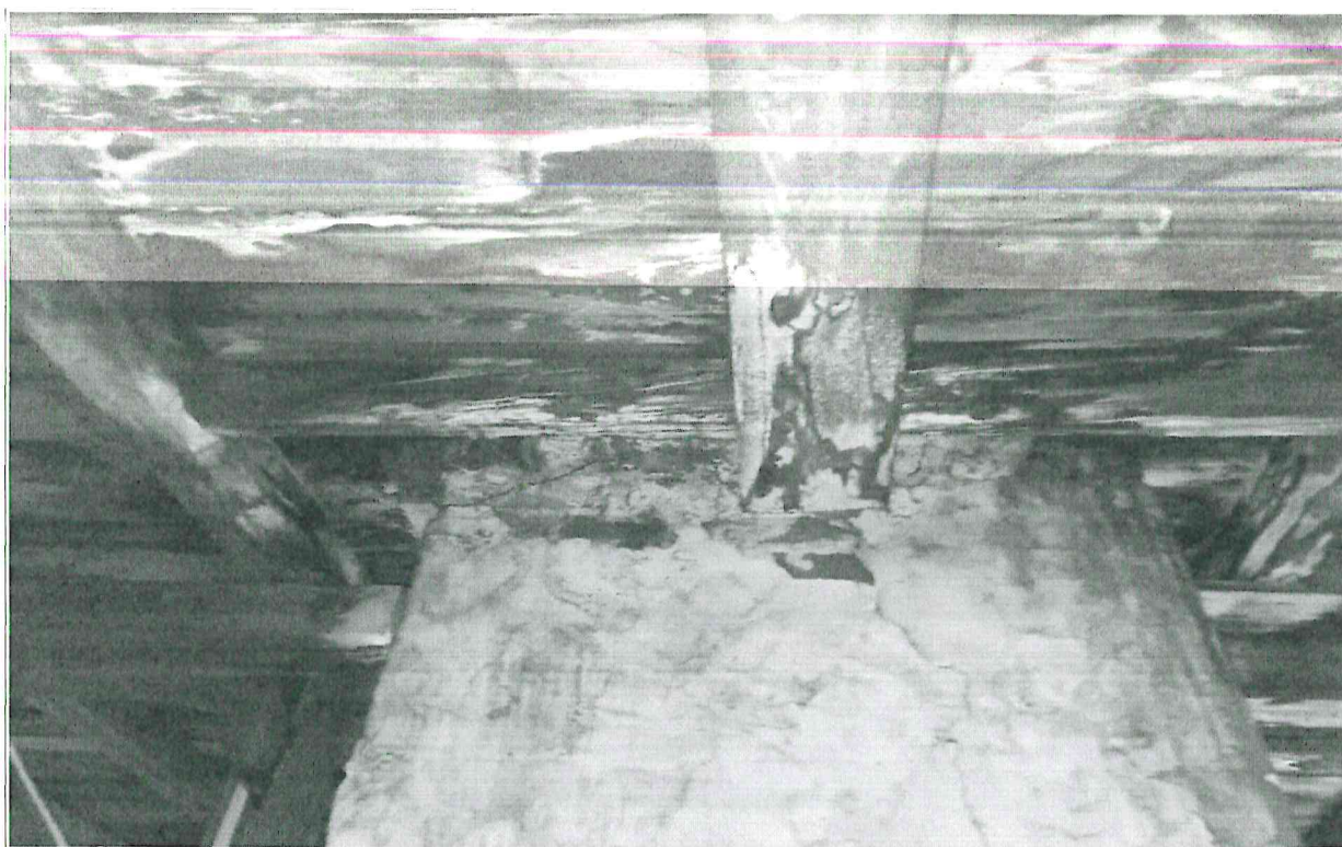
Fot. nr 37,38 – widoczne miejscowo wzmocnienia konstrukcji drewnianej więźby dachowej, wzmocnienia wykonywane prowizorycznie, bez odpowiedniego zamontowania (łączenia) nowych elementów konstrukcyjnych z istniejącymi i bez prawidłowego zabezpieczenia nowych elementów konstrukcyjnych przeciwko korozji biologicznej. Widoczne znaczne zacieki wody opadowej na nowych elementach, brak kompleksowego zabezpieczenia konstrukcji dachu przed dalszą degradacją wskutek nieszczelności połaci dachu.
