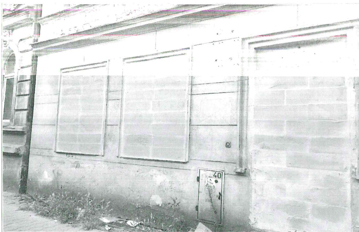
Fot. nr 31,32 – widok elewacji frontowej, otwory okiennej z poziomu parteru zamurowane od zewnątrz, co powoduje znaczne zawilgocenie pomieszczeń na parterze, gdyż występuje brak odpowiedniej cyrkulacji powietrza na danych obszarze. Obecnie występuje znaczna degradacja pomieszczeń parteru wskutek dużego zawilgocenia danych pomieszczeń – zawilgocenie ogólne budynku, brak cyrkulacji powietrza, brak wentylacji grawitacyjnej nawiewnej jak i wywiewnej. Należy zapewnić prawidłową cyrkulację powietrza zgodnie z niniejszym opracowaniem.
