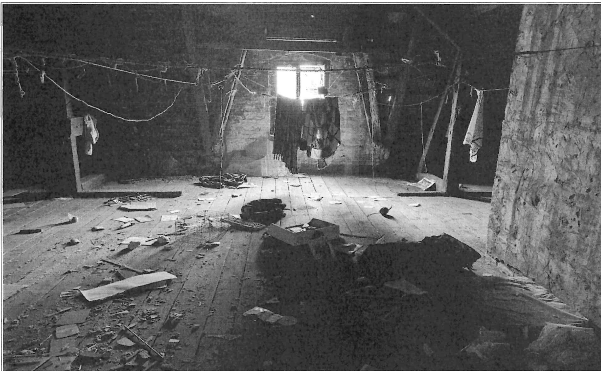
Fot. nr 39,40 – widok pomieszczeń strychu danego budynku, miejscowo występują przecieki wody opadowej przez nieszczelności pokrycia dachu i obórek blacharskich, miejscowo widoczne świeże przecieki przez połacie dachu – widok posadzki w poziomie strychu. Woda opadowa powoduje znaczną degradację więźby dachowej (drewna) i murów ceglanych budynku. Należy wykonać remont połaci dachu zgodnie z niniejszym opracowaniem. Dodatkowo w poziomie strychu widoczne śmieci, gruz itp., co może powodować niebezpieczeństwo pożarowe dla danego obiektu.
