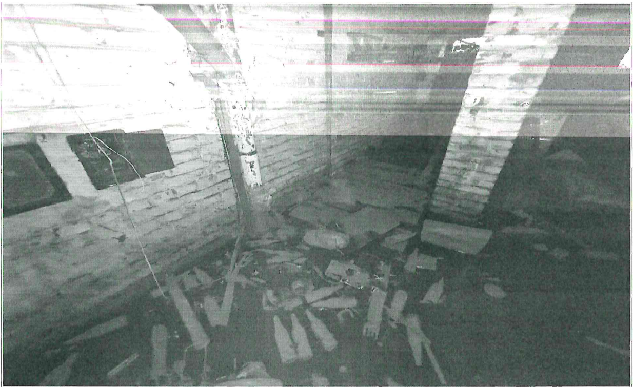
Fot. nr 13,14 – pomieszczenie piwnicy, widok braku posadzek w części pomieszczeń piwnicznych (podłoże gruntowe) , brak izolacji posadzek oraz murów ceglanych, występuje w piwnicy znaczne zawilgocenie wskutek braku izolacji, braku odpowiedniej cyrkulacji powietrza (brak odpowiedniej wentylacji), w pomieszczeniach piwnicznych bieżąca konserwacja ani remont nie był wykonywany od kilkunastu/kilkudziesięciu lat. Tynki zmuśzałe na ścianach, zawilgocone, porażone korozją biologiczną. W pomieszczeniach piwnicznych należy wykonać generalny remont zgodnie z niniejszym opracowaniem – co zapewni zabezpieczenie całego budynku przed dalszą degradacją. Widoczna stojąca woda w poziomie posadzek – woda opadowa, gruntowa i prawdopodobnie z nieszczelnej instalacji kanalizacji deszczowej (woda wybija przez studzienki w piwnicy).
