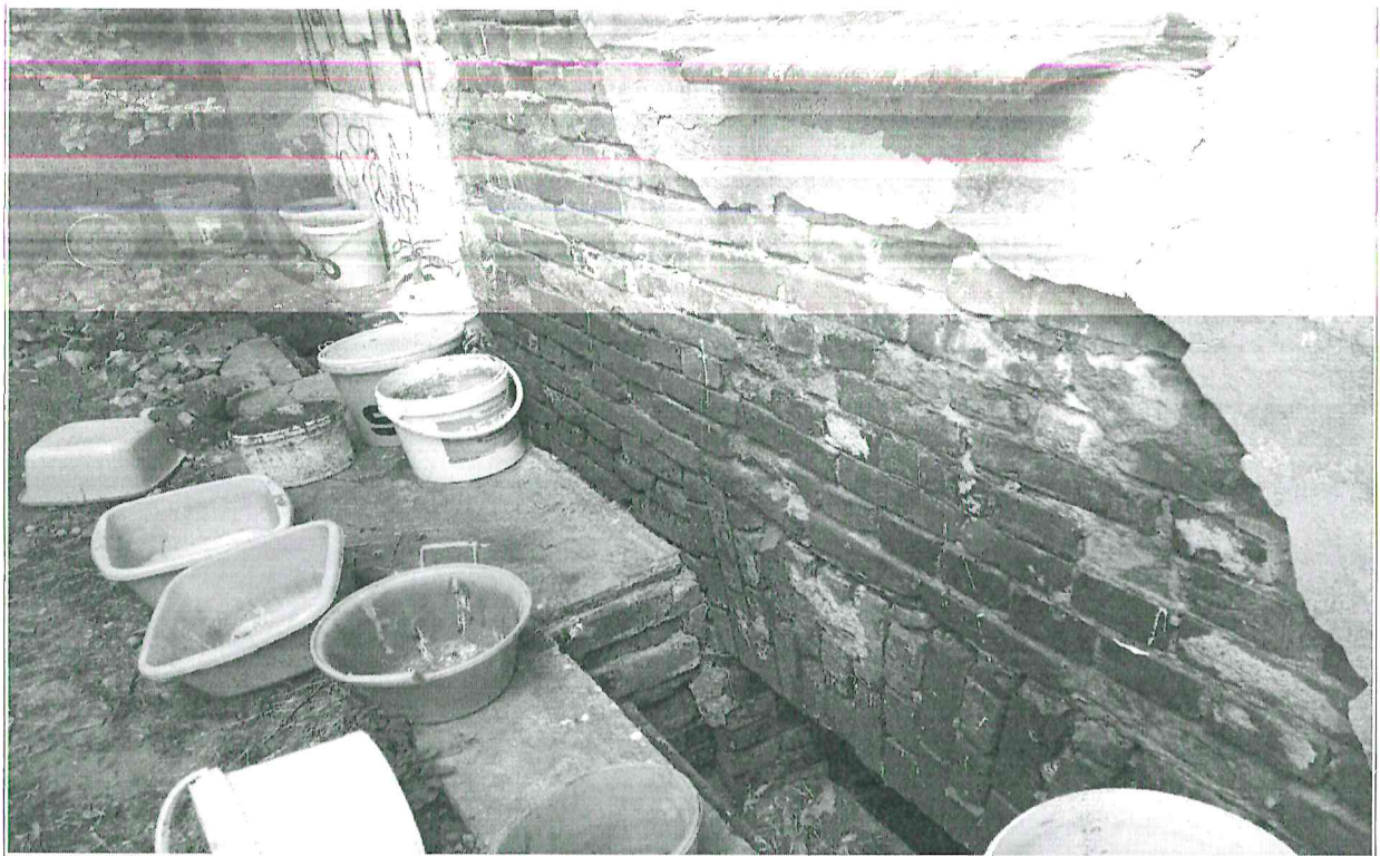
Fot. nr 5,6 – widok cokołu budynku (elewacja tylna), degradacja tynku i muru ceglanego wskutek brak izolacji pionowej i poziomej, brak spadków od budynku – podciąganie kapilarne wody opadowej przez mur ceglany. Widoczne zmuśnienie tynków w strefie cokołowej budynku, tynki odspajają się do muru ceglanego, widoczna znaczna degradacja i korozja biologiczna muru ceglanego (mech, glony i inne roślinność). Nieszczelna rura spustowa (urwana na wysokości kilku metrów od ziemi – całość wody opadowej zalewa od dawna elewację budynku), woda opadowa powoduje degradację muru ceglanego, brak odpowiedniego zabezpieczenia strefy cokołowej budynku.
