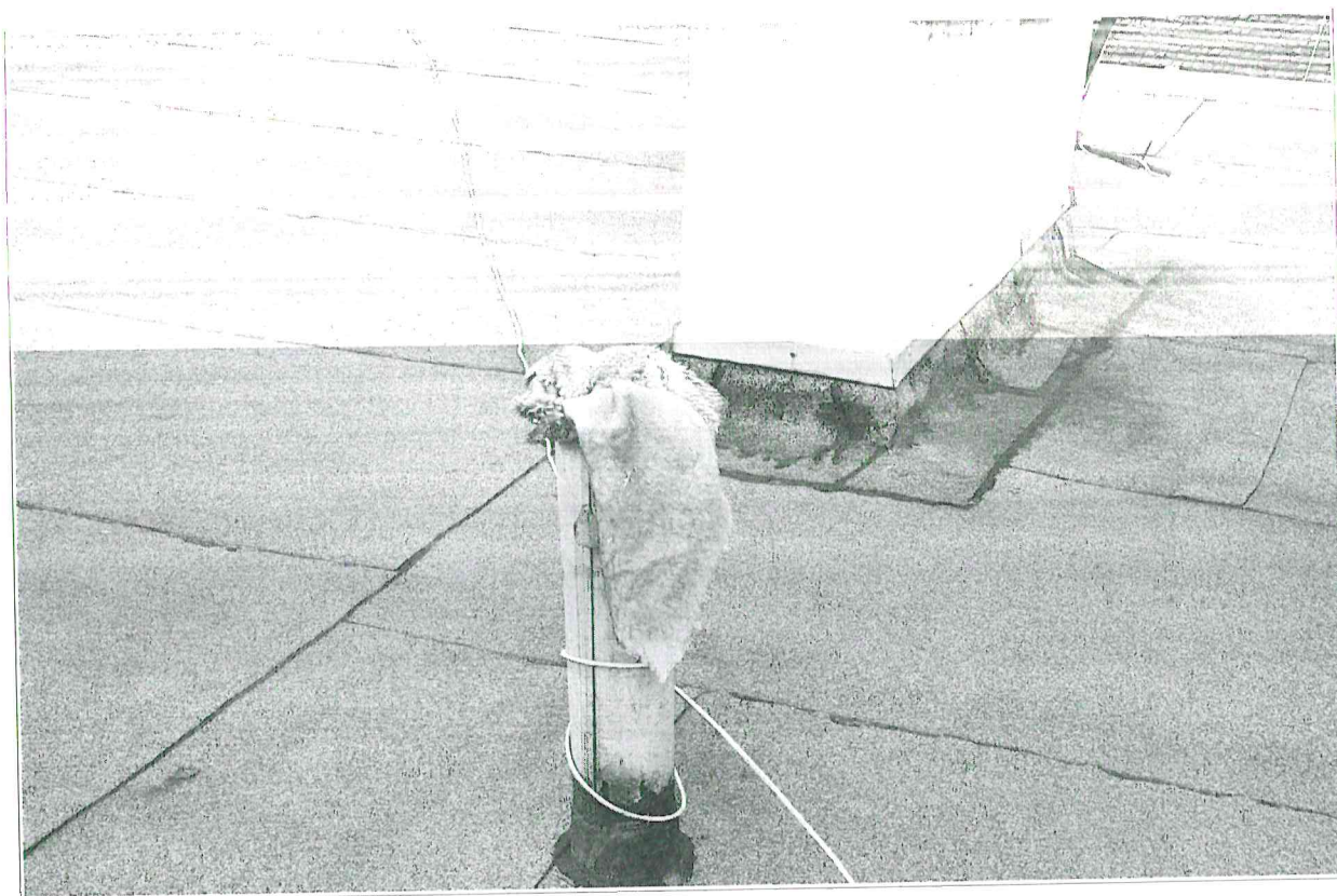
Fot. nr 45,46 – widok obróbek blacharskich na polaci dachu, obróbki w większości stare, skorodowane, nieszczelne, należy wykonać montaż nowych obróbek blacharskich na ogniomurach, wokół kominów dymowych i przewodów wentylacyjnych, obecnie obróbki blacharskie nie spełniają już swojego przeznaczenia, a prowizoryczne naprawy przyczyniły się do dodatkowego pogorszenia stanu technicznego całej polaci dachu. Dodatkowo widoczny zły stan techniczny dachówki na stromej części polaci dachu, widoczne są luźne dachówki oraz pozostałości po płotkach przeciw śniegowych – do demontażu owe deski, zagrożenie dla osób postronnych na dole.
