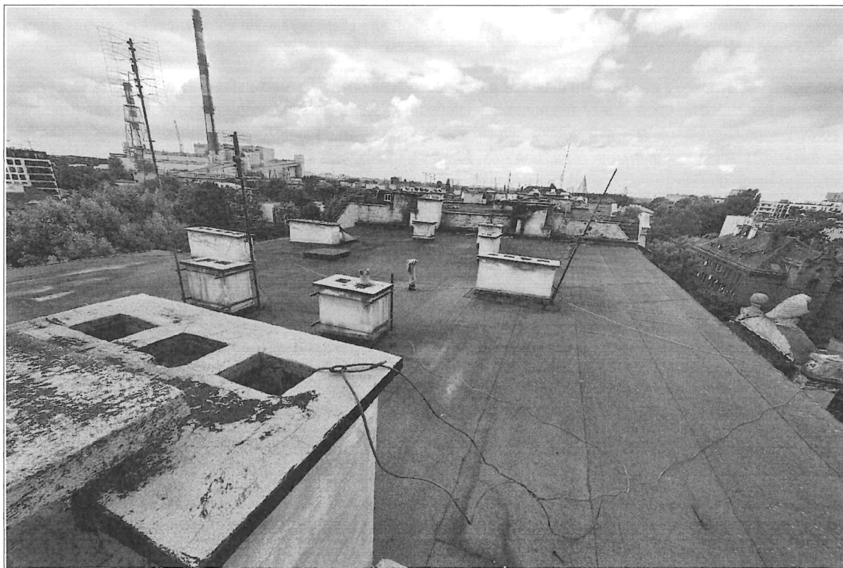
Fot. nr 47 – widok nieprawidłowo zakończonych kominów dla danego budynku, wszystkie kominy są zakończone w taki sposób, należy wykonać prawidłowe zwieńczenie wylotów bocznych kominów zgodnie z niniejszym opracowaniem.
