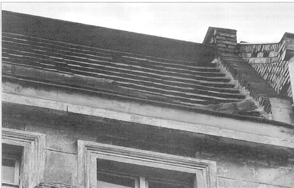
Fot. nr 52,53 – elewacja frontowa budynku, widoczne miejscowe spękania ścian zewnętrznych budynku, elementy gzymsu także zmurzałe i porażone przez korozję biologiczną. Całość obecnie należy zabezpieczyć, tj. skuć luźne elementy i gzyms osiatkować. Dodatkowo należy usunąć ze stromej połaci dachu – leżą tam luźne desek (kiedyś płotek przeciw śniegowy), zagrożenie dla osób postronnych na dole. Elementu ozdobne gzymsu należy odtworzyć na wzór istniejących (rysunki archiwalne) zgodnie z przyjętą technologią naprawy tego elementu, budynek znajduje się pod ochroną konserwatorską – tak więc technologię i zakres remontu należy uzgodnić na etapie projektu budowlanego z MKZ.
