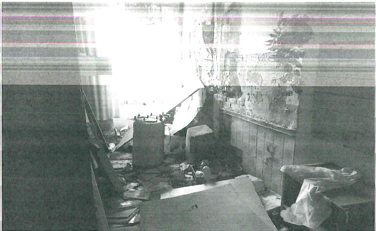
Fot. nr 95,96 – widoczne zniszczone łazienki wraz z instalacjami wod.-kan., całość instalacji sanitarnych uszkodzona i zdekompletowana, należy wykonać nowe instalacje sanitarne w całym obiekcie.
