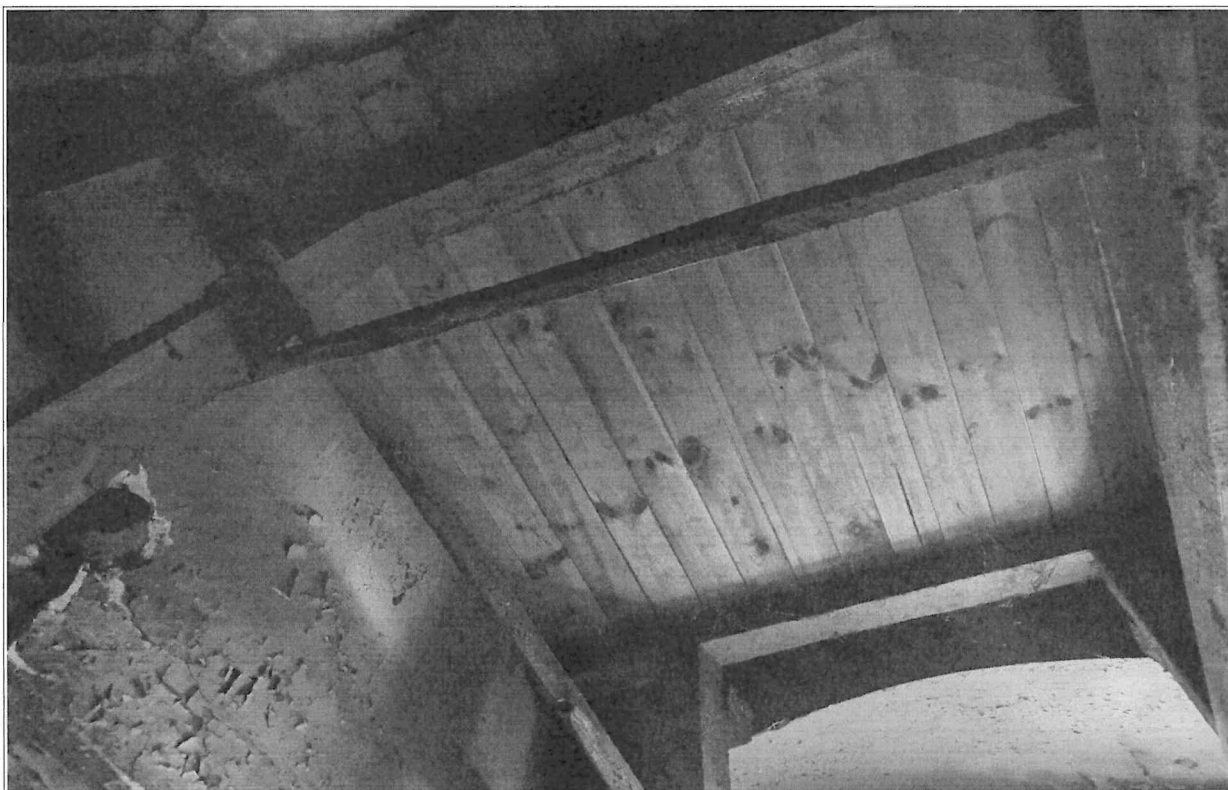
Fot. nr 74,75 – widok spoczników klatki schodowej, w części skuto tynki, widoczne obecnie stalowe belki wraz z wypełnieniem ceglanym, część spoczników w złym stanie technicznym, obecnie zabezpieczone poprzez pełne deskowanie i stemplowanie. Należy wykonać generalnym remont owych elementów konstrukcyjnych budynku poprzez oczyszczenie belek stalowych, zabezpieczanie ich antykorozyjnie oraz po dokładnym oczyszczeniu możliwe ich wzmocnienie poprzez dodatkowe podparcie w poprzek danych elementów. Część spocznika na parterze nadaje się tylko do wymiany na nowe elementy konstrukcyjne, np. poprzez zastosowanie systemowego stropu WPS lub równoważnego.
