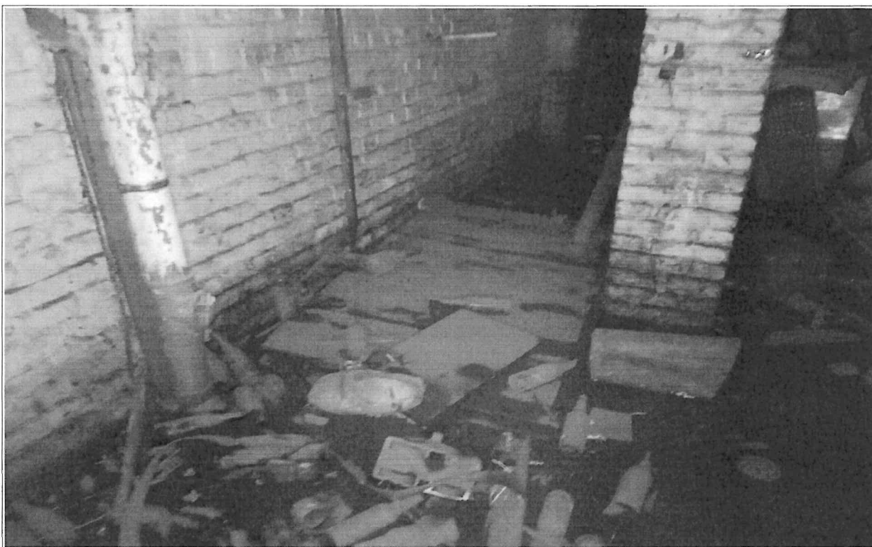
Fot. nr 11,12 – pomieszczenie piwnicy, tynki zmuśnięte, porażone korozją biologiczną, zarówno tynki jak i mury wykazują zawilgocenie jak i zalanie wodą opadową i gruntową, brak izolacji budynku, brak odpowiedniego odprowadzania wód opadowych, piwnice wykazują znaczną degradację w wyniku zawilgocenia, zagrzybienia pleśniowego oraz wykwitów solnych. Brak izolacji pionowej i poziomej ścian fundamentowych oraz brak izolacji poziomej posadzki w pomieszczeniach piwnicznych – co przyczynia się do znacznej degradacji pomieszczeń piwnic i strefy przyziemia budynku. Należy wykonać generalny remont pomieszczeń piwnicznych tj. posadzek, ścian oraz warstw wykończeniowych stropów.
