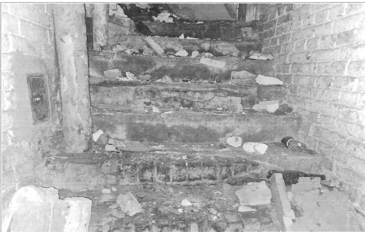
Fot. nr 15,16 – widok pomieszczeń piwnicy, brak stolarki okiennej, znaczne zawilgocenie ścian i posadzek (jak i schodów do piwnicy), co powoduje do akumulacji wilgoci dochodzi poprzez gnicie stert śmieci itp./ brak cyrkulacji powietrza (brak prawidłowej wentylacji pomieszczeń), brak izolacji posadzek i ścian, to wszystko powoduje, iż pomieszczenia piwniczne obecnie są znacznie zdegradowane i nie nadają się do użytkowania. Należy wykonać niezbędne roboty budowlane, które zapobiegą dalszej degradacji całego obiektu wskutek wszechobecnej wody w pomieszczenia piwnicy. Schody wskutek destrukcji zagrażają bezpieczeństwu ich użytkowania.
