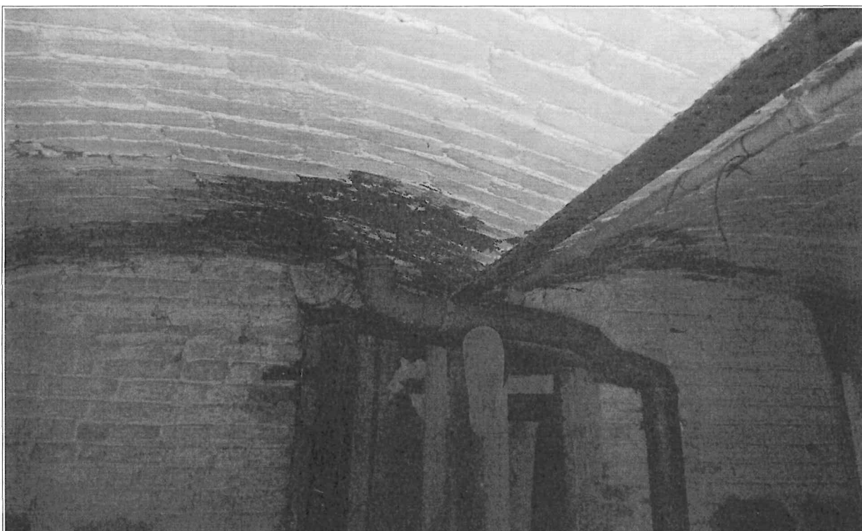
Fot. nr 66,67 – widok części stropu ceglanego typu Kleina i ścian pomieszczeń piwnicznych, widoczne uszkodzenia sklepień łukowych nad przejściami oraz instalacje prowadzone przez przegrody budowlane bez odpowiednich tulei ochronnych. Tynki na stropach oraz ścianach w większości zmuśrzałe, porażone korozją biologiczną. W pomieszczeniach piwnicznych występuje znaczne zawilgocenie posadzek, ścian i stropów. Należy wykonać kompleksowy remont pomieszczeń piwnic zgodnie z niniejszym opracowaniem dla każdego z elementów budowlanych.
