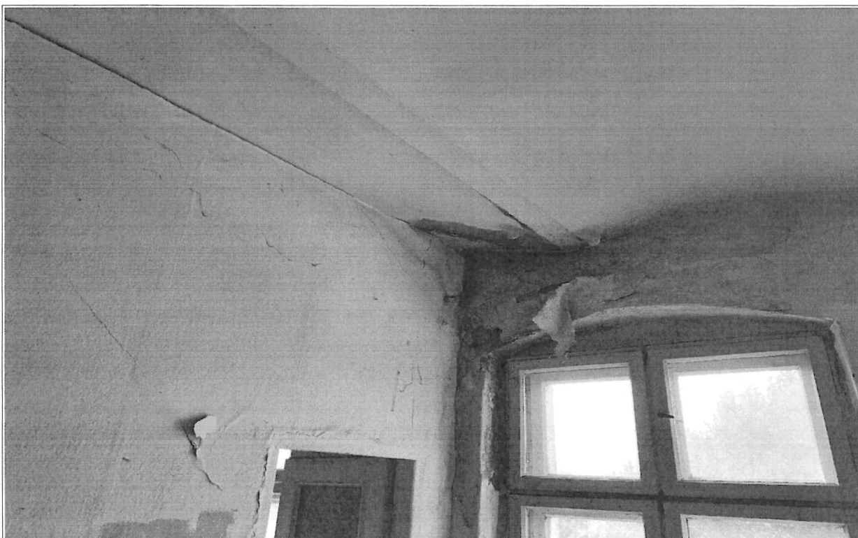
Fot. nr 25,26 – widoczne zalania stropu i ścian danych mieszkań, widoczne stare i nowe zalania pomieszczeń, zalania spowodowane nieszczelnościami połaci dachu wraz nieszczelnymi obróbkami blacharskim np. gzymsów, należy wykonać remont połaci dachu oraz wykonaniem nowych obróbek blacharskich na elewacjach budynku wraz z remontem danych lokali (skucie tynków, osuszenie, odgrzybienie, wykonanie nowych warstw tynków wraz z malowaniem).
