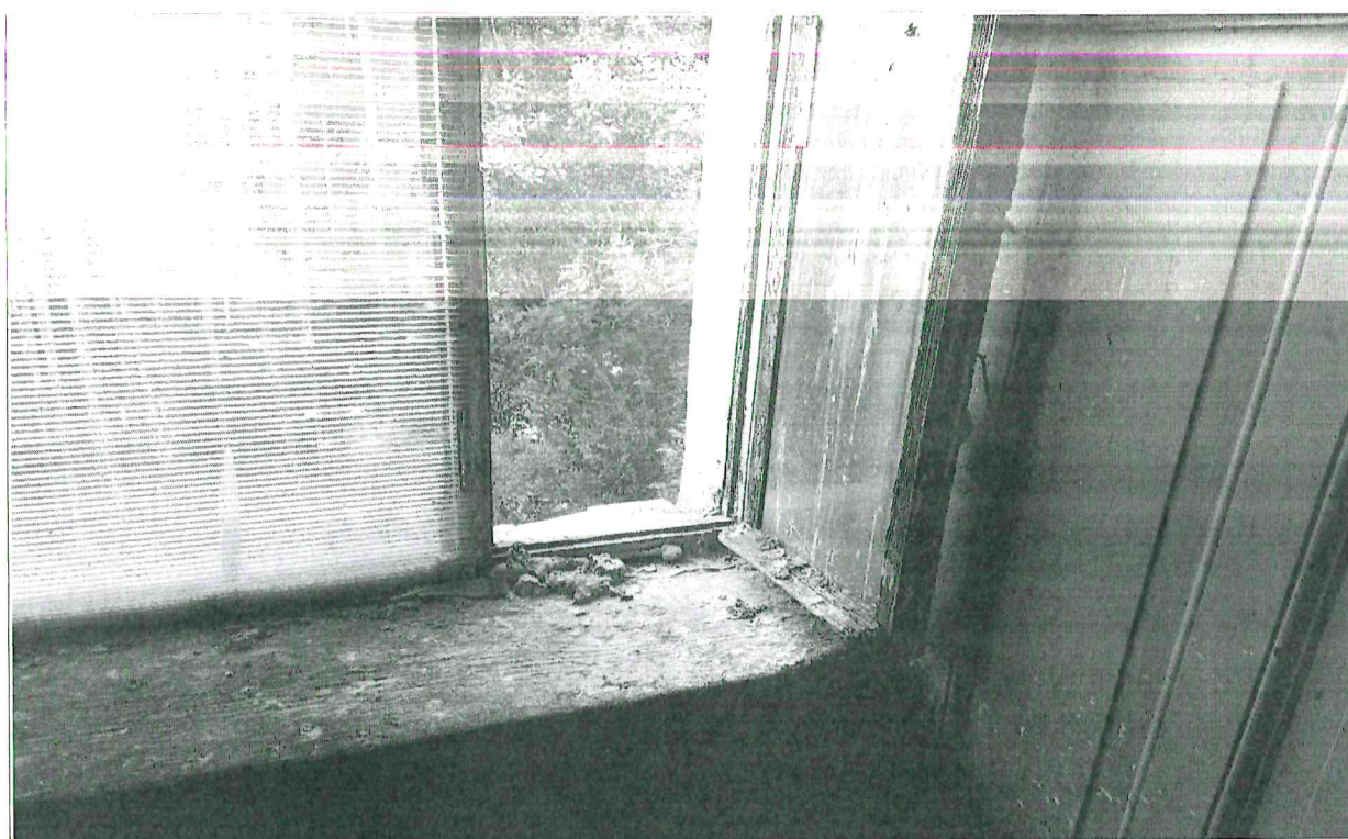
Fot. nr 19,20 – brak prawidłowej izolacyjności przegród budowlanych budynku, co powoduje występowanie zawilgocenia pleśniowego na ścianach budynku. Należy wykonać docieplenie ścian zewnętrznych budynku zgodnie z danym opracowaniem. Stolarka okienna w znacznej części w złym stanie technicznym, stolarka stara, wypaczona, bez odpowiedniej izolacyjności cieplnej, części lokali (pustostanów) od dłuższego czasu nie ogrzewana, co znacznie pogarsza warunki wilgotnościowe w budynku, brak odpowiedniej cyrkulacji powietrza, okna nie wyposażone w nawiewniki. Całość stolarki nadaje się tylko do wymiany na nową.
