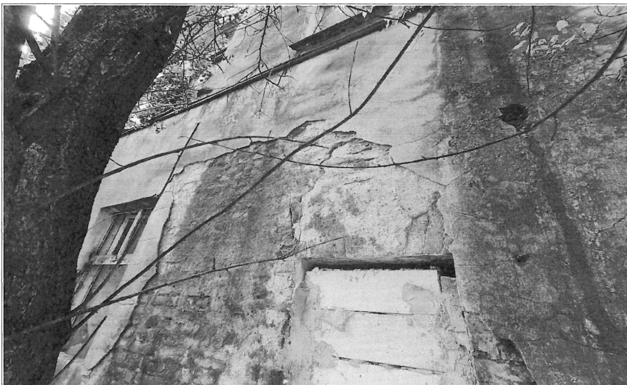
Fot. nr 7,8 – elewacja tylna budynku, widok strefy cokołowej budynku, brak odpowiednich spadków terenu od budynku, brak stolarki okiennej w pomieszczeniach piwnicznych lub otwory okienne prowizorycznie zabezpieczone, widoczne znaczne spękania tynków i ich odparzenie. Widoczne znaczne zmurszenie tynków w strefie cokołowej budynku, tynki odspajają się do muru ceglanego, widoczna znaczna degradacja i korozja biologiczna muru ceglanego. Brak izolacji pionowej i poziomej przeciwwilgociowej powoduje znaczną degradację strefy cokołowej danego obiektu. Należy wykonać prace naprawcze elewacji budynku zgodnie z niniejszym opracowaniem. Dodatkowo widoczna urwana rura spustowa (kilka metrów od poziomu gruntu) – długotrwała degradacja elewacji budynku – zmurszenie tynków i zagrzybenie pleśniowe.
