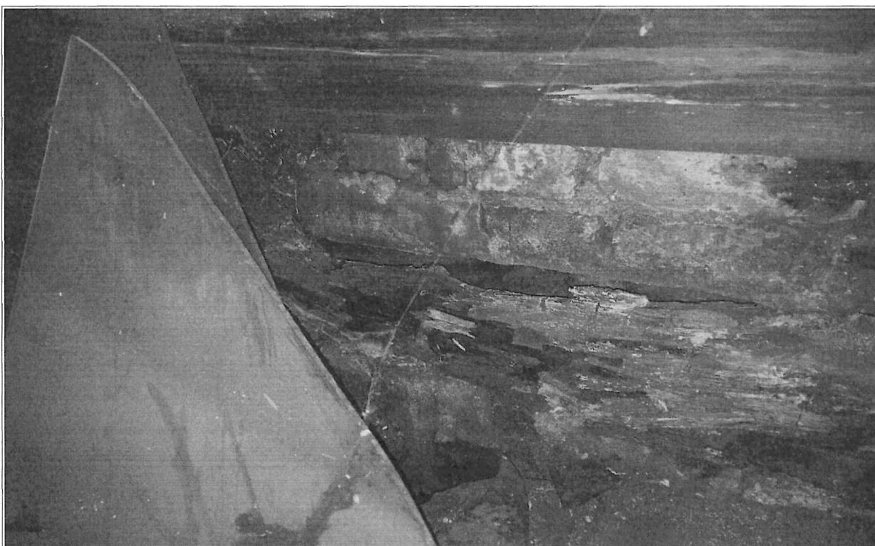
Fot. nr 35,36 – widok więźby dachowej budynku, widoczna korozja biologiczna drewnianych elementów konstrukcyjnych, drewno miejscowo porażone przez grzyby oraz przez owady, występuje zmurszenie drewna wskutek zawilgocenia, należy wykonać mechaniczne oczyszczenie konstrukcji dachu, wymianę lub wzmocnienie uszkodzonych elementów oraz impregnację całej więźby dachowej wg opisu niniejszego opracowania. Widoczne są obecnie przecieki przez połac dachu wody opadowej. Należy wykonać wymianę danych elementów konstrukcyjny na nowe elementy konstrukcyjne (drewno klasy C24) o tym samym przekroju i wymiarach. Całość konstrukcji więźby dachowej po mechanicznym oczyszczeniu należy zaimpregnować środkami wskazanymi w niniejszym opracowaniu.
