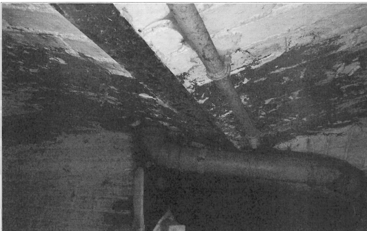
Fot. nr 97,98 – widok skorodowanych instalacji wod.-kan. instalacje nie były poddawane od wielu lat bieżącej konserwacji – całość instalacji wod.-kan. oraz gazowej do wymiany na nowe zgodnie z niniejszym opracowaniem.
