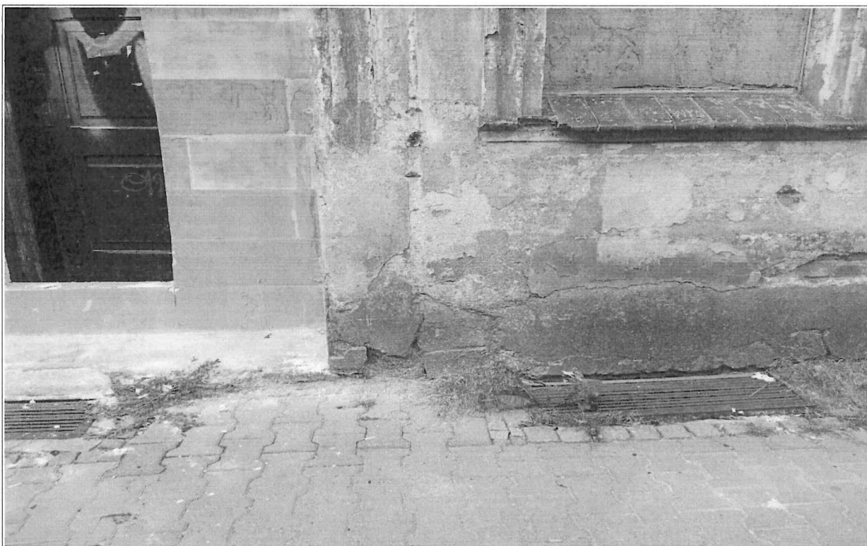
Fot. nr 3,4 – widok cokołu budynku (elewacja frontowa), degradacja tynku i muru ceglanego wskutek brak izolacji pionowej i poziomej, zaleganie wody opadowej wokół budynku, chodnik wzdłuż budynku nierówny, występują liczne ubytki, brak spadków od budynku, obecnie przeciwwspadki – podciąganie kapilarne wody przez mur ceglany. Widoczne zmurszenie tynków w strefie cokołowej budynku, tynki odspajają się do muru ceglanego, widoczna znaczna degradacja i korozja biologiczna muru ceglanego. Otwory okienne w poziomie przyziemia prowizorycznie zabezpieczone. Brak odpowiedniej cyrkulacji powietrza w poziomie parteru budynku (otwory okienne obecnie zamurowane).
