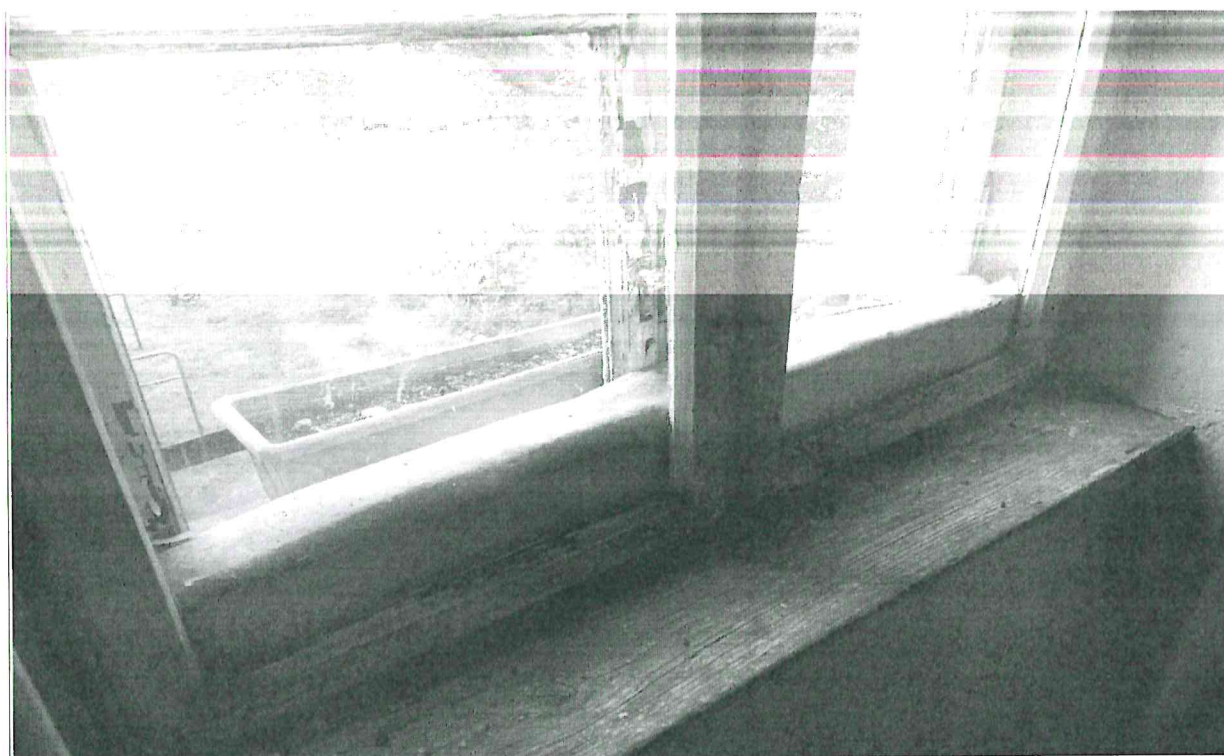
Fot. nr 27,28 – widoczna stara, drewniana stolarka okienna w lokalach mieszkalnych, bez odpowiednich parametrów technicznych (izolacyjność cieplna). Całość stolarki drewnianej nadaje się tylko do wymiany na nową, zespoloną z PVC lub drewnianą (do uzgodnienia z Miejskim Konserwatorem Zabytków) – wraz systemowymi nawiewnikami powietrza. Stolarka od lat nie poddawana bieżącej konserwacji, stolarka nie domyka się, częściowo pozbawiona szklenia, wypaczona. Widoczne prowizoryczne uszczelnianie stolarki okiennej przed zimnem od strony zewnętrznej – stolarka nie spełnia odpowiednich warunków izolacyjność cieplnej. Całość stolarki okiennej w budynku nadaje się do wymiany na nową o obowiązujących parametrach technicznych, dodatkowo należy wykonać wymiany parapetów i obróbkę zewnętrznych – obecnie stan istniejących powoduje zalewanie lokali wskutek nieszczelności i złego ich stanu technicznego.
