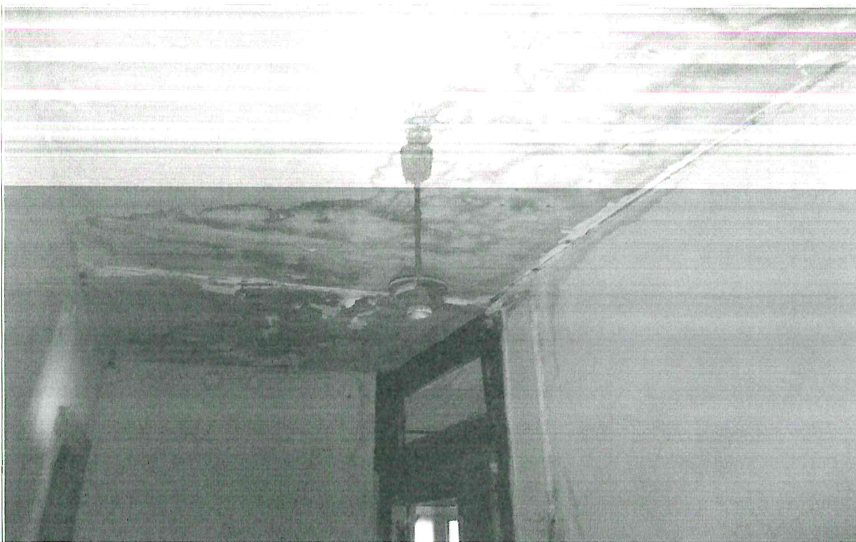
Fot. nr 72,73 – widoczne zalania stropów mieszkalnych, miejscowo występują ponadnormatywne ugięcia stropów, w większości lokali są jeszcze stare tynki wapienne na trzcinie. Obecnie dodatkowo drewniane stropu lokali wykazują już znaczne uszkodzenia warstw wykończeniowych (np. poprzez wydzieloną samowolnie łazienki oraz nieszczelne instalacje wod.-kan.) Należy przewidzieć w przyszłości remont/wymianę stropów zgodnie z niniejszym opracowaniem.
