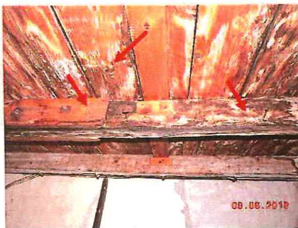
Fot. 20. Kolejne miejsce konstrukcji po długotrwałych zawilgoceniach, widoczna nadbitka płatwi
