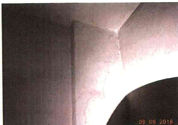
Fot. 47. Spękania tynku na kominie w wydzielonym lokalu na parterze
