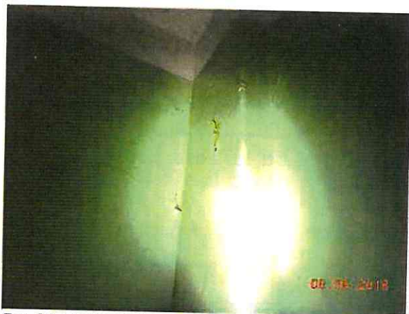
Fot. 50. Spękania tynku i złuszczenia powłoki malarskiej na tynku w łazience na parterze w wydzielonym lokalu
