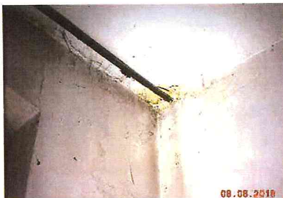
Fot. 45. Ślady po zielenicach na tynku pod sufitem – wydzielony lokal na parterze
