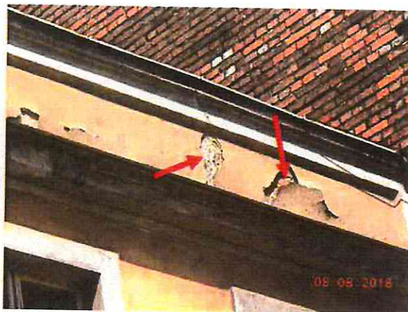
Fot. 33. Ubytki i odspojenia tynku na elewacji frontowej
