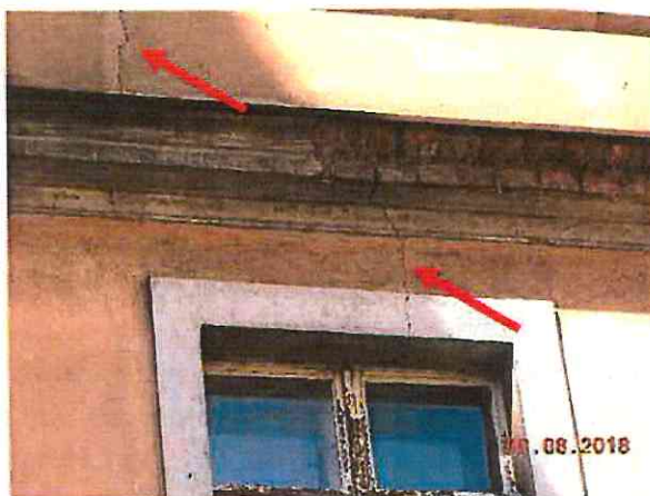
Fot. 26. Spękanie tynku nad oknem od ulicy. W miejscu ubytku tynku na przedłużeniu rysy widoczna fuga w murze z cegły
