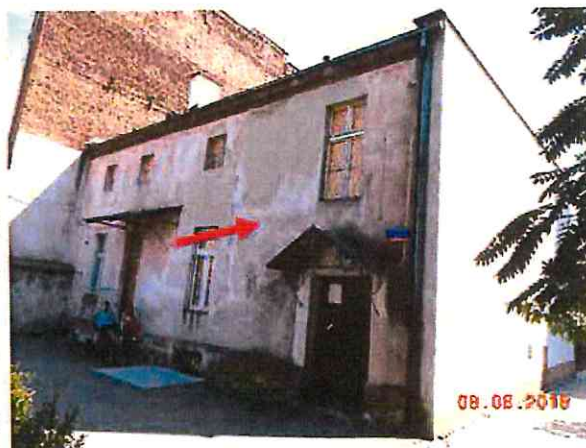
Fot. 31. Ślady napraw tynku na elewacji tylnej
