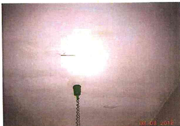
Fot. 46. Ślady po zawilgoceniu tynku na suficie – lokal na parterze
