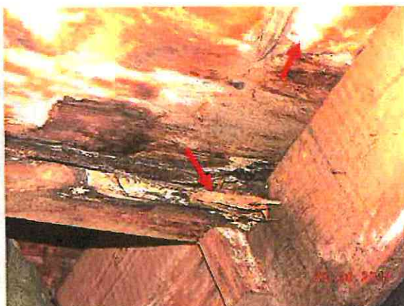
Fot. 19. Wielokrotnie zalewana konstrukcja dachu widoczne ślady próchnicy na deskach i belkach
