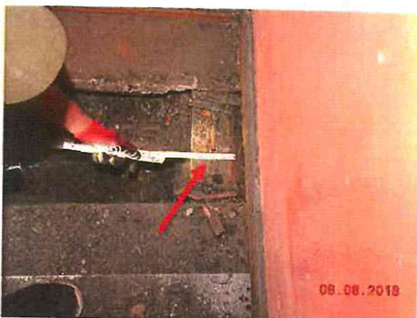
Fot. 9. Pomiar szerokości belki: ca. 12,5 cm
