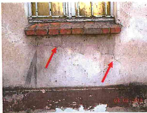
Fot. 38. Ślady naprawy tynku na elewacji
