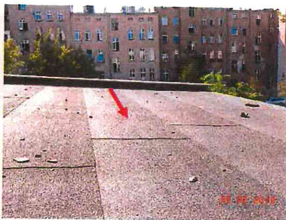
Fot. 16 Nawierzchnia z papy i widoczny gruz na papie
