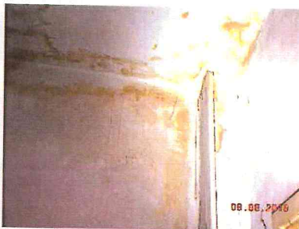
Fot. 43. Ślady po zalaniu tynku na styku ścian i sufitu wydzielony lokal na parterze
