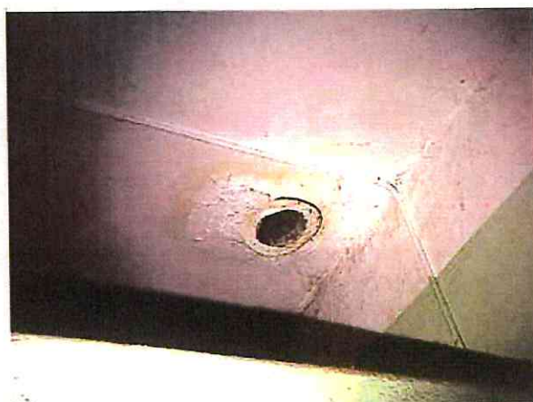
Fot. 49. Ślady po zalaniu tynku na suficie przy otworze wentylacyjnym w wydzielonym lokalu na parterze
