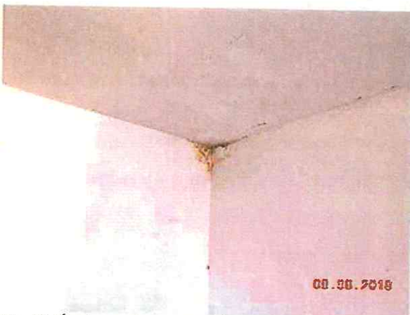
Fot. 42. Ślady po starym zacieku w narożu ścian pod sufitem – I-sze piętro
