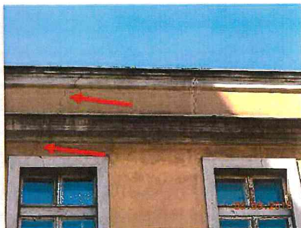
Fot. 25. Spękania tynku nad i pod gzymsem górnym
