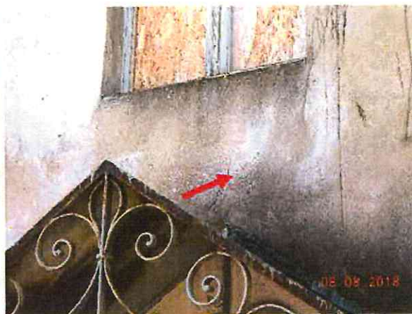
Fot. 37. Spękania tynku i ślady po naprawach od tyłu budynku
