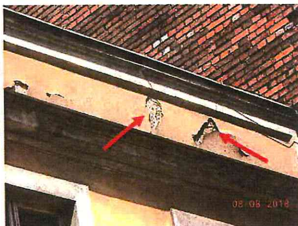
Fot. 27. Spękanie i ubytki tynku w strefie nad gzymsem górnym
