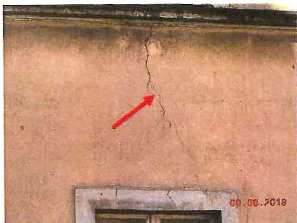
Fot. 24. Spękanie tynku nad oknem od ulicy
