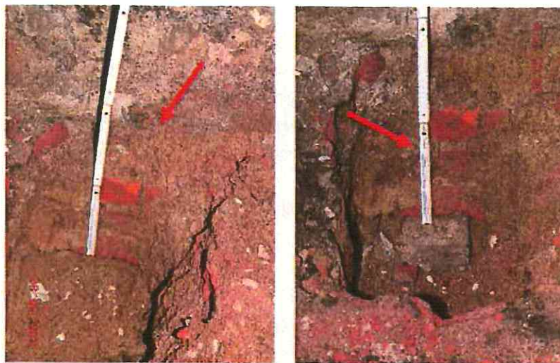
Fot. 3 i 4. Odkrywka fundamentu w piwnicy. Poziom posadowienia 38 cm poniżej poziomu posadzki w piwnicy
