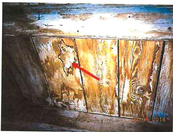
Fot. 22. Miejsce po długotrwałych i wielokrotnych zawilgoceniach drewna – desek poszycia i krokwi
