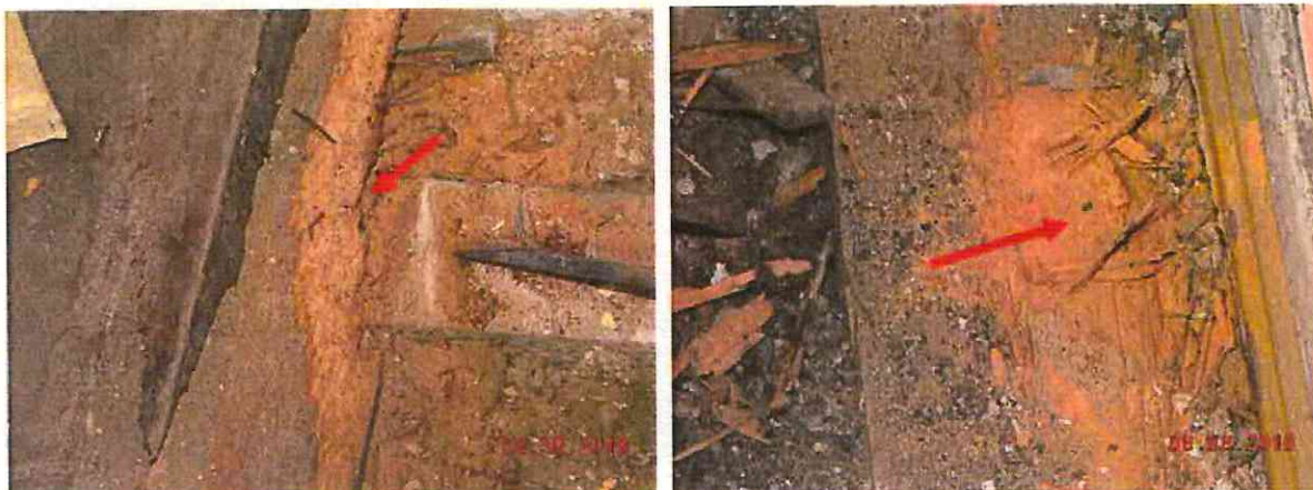
Fot. 11 i 12. Widoczna próchnica desek podłogowych i znajdujących się pod nimi belek stropowych.
