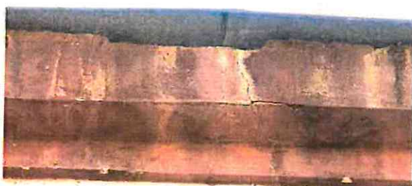
Fot. 40 i 41. Ubytki tynku na gzymsie pod dachem od strony podwórka
