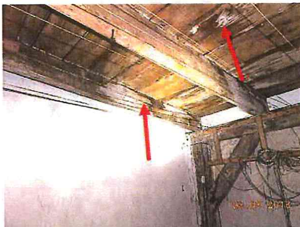
Fot. 18. Deskowanie dachu od spodu, widoczne ślady po zawilgoceniu drewna po zalaniach z nieszczelności dachu
