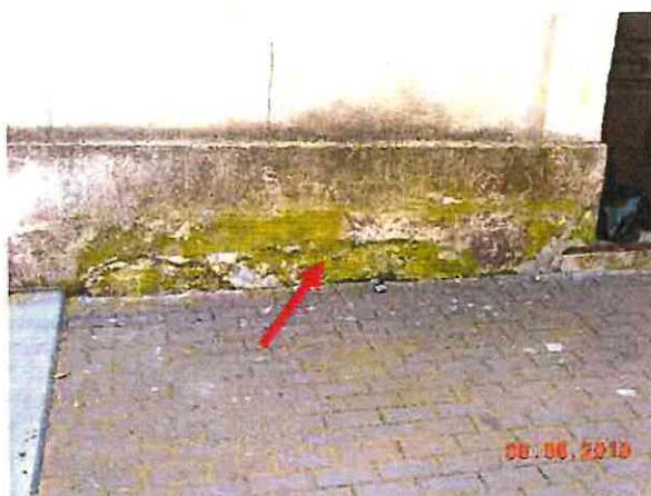
Fot. 36. Zielenice i spękania cokołu od podwórka
