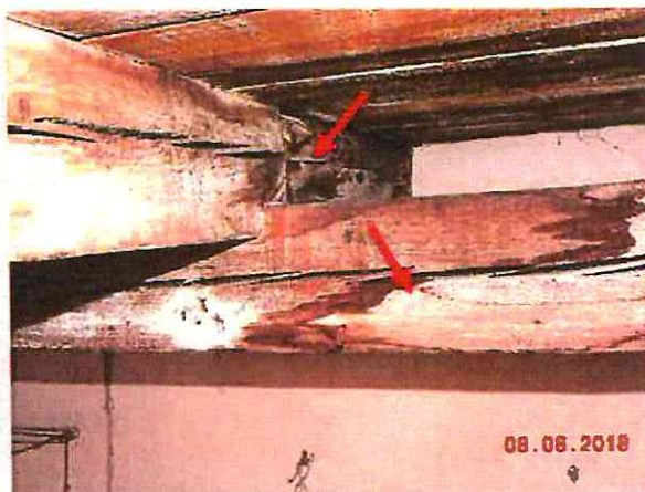
Fot. 21. Wymieniony fragment krokwi, ślady po długotrwałych i wielokrotnych zawilgoceniach drewna
