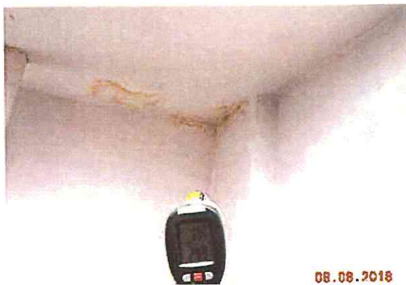
Fot. 44. Ślady po zalaniu na styku ścian i sufitu lokal na I-szym piętrze
