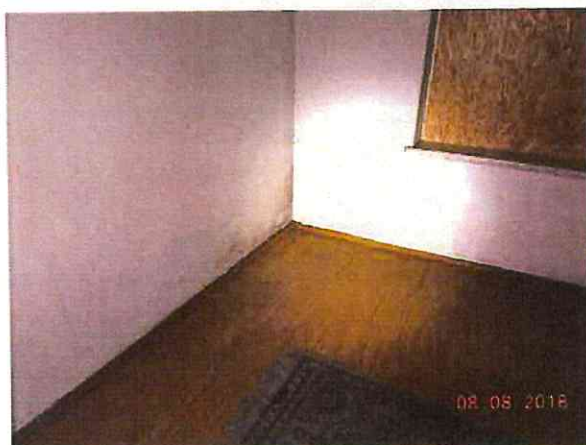
Fot. 48. Ślady po zawilgoceniu tynku w wydzielonym lokalu na parterze
