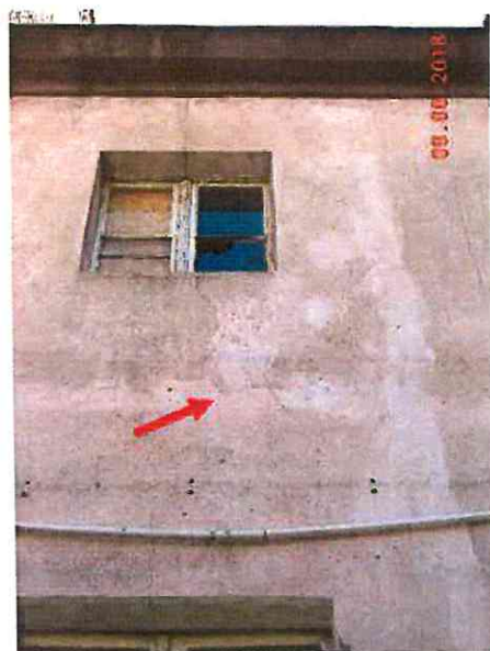
Fot. 38. Ślady naprawy tynku na elewacji
