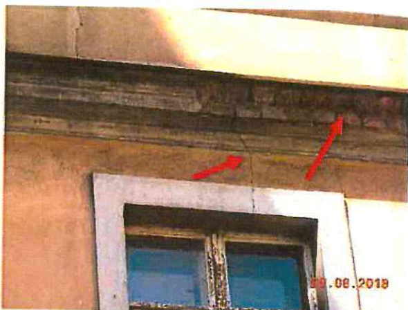
Fot. 32. Ubytek tynku na gzymsie od frontu, spękania tynku nad oknem
