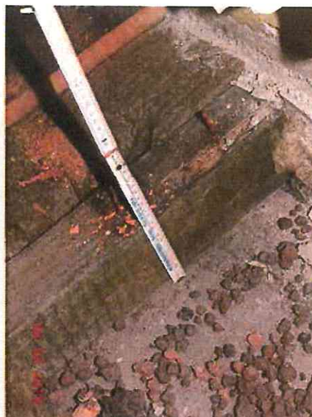
Fot. 6. Pomiar legara: 8x12 cm na stropie widoczny keramzyt
