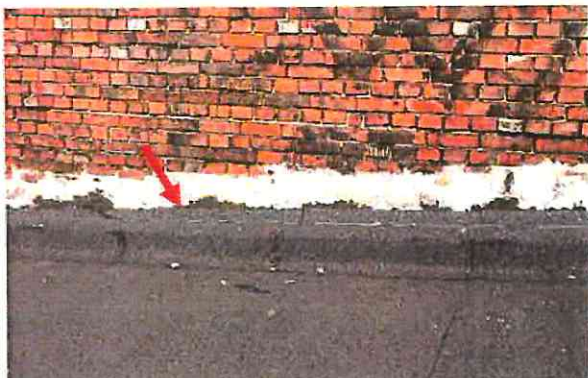
Fot. 17. Połączenie dachu nad przedmiotowym budynkiem z budynkiem sąsiednim
