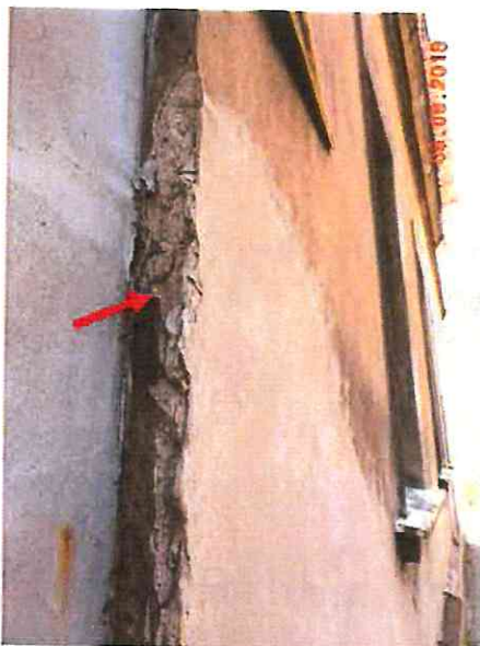
Fot. 34. Uszkodzenia tynku na krawędzi budynku przy elewacji bocznej, docieplonej
