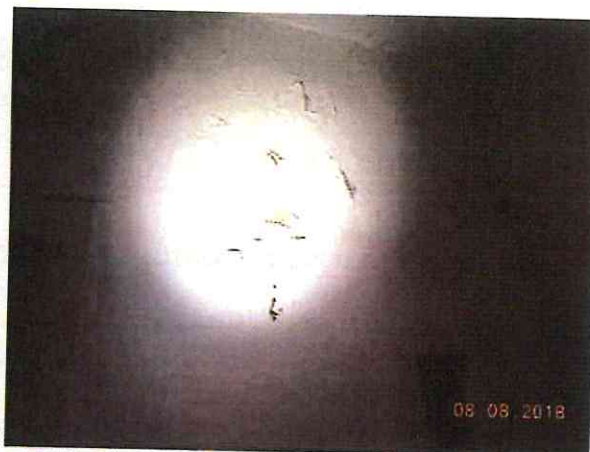
Fot. 51. Złuszczenia farby na tynku w kuchni w wydzielonym lokalu na parterze
