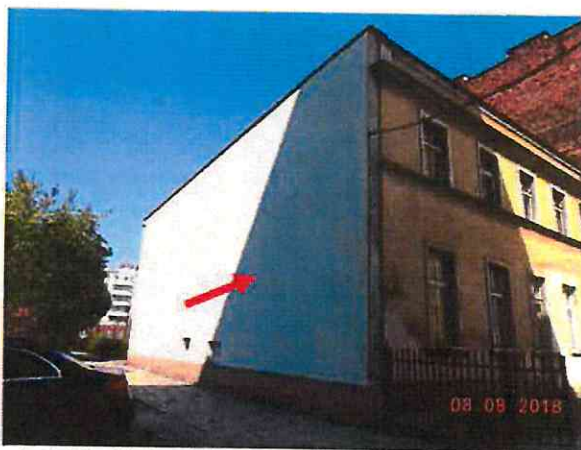
Fot. 35. Elewacja boczna – docieplona metodą lekką mokrą
