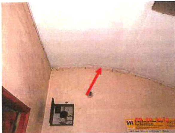
Fot. 28. Konstrukcja schodów – sklepienie beczkowe na belkach stalowych
