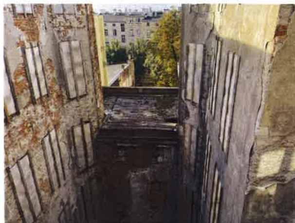
Spękany komin do rozebrania lub wzmocnienia PILNE
