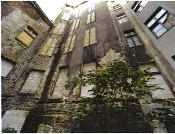
Zniszczenia ścian zewnętrznych
