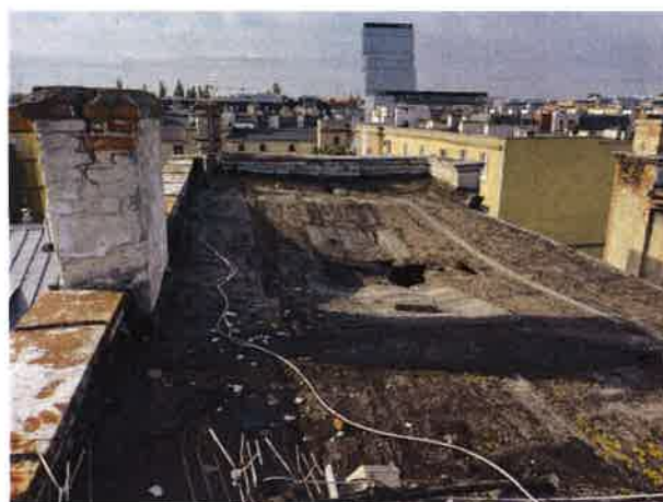
Zapadnięta konstrukcja dachu
