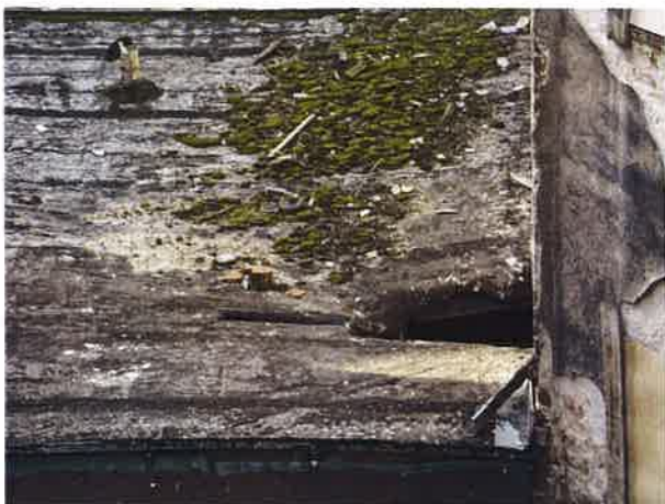
Zapadnięta konstrukcja dachu
