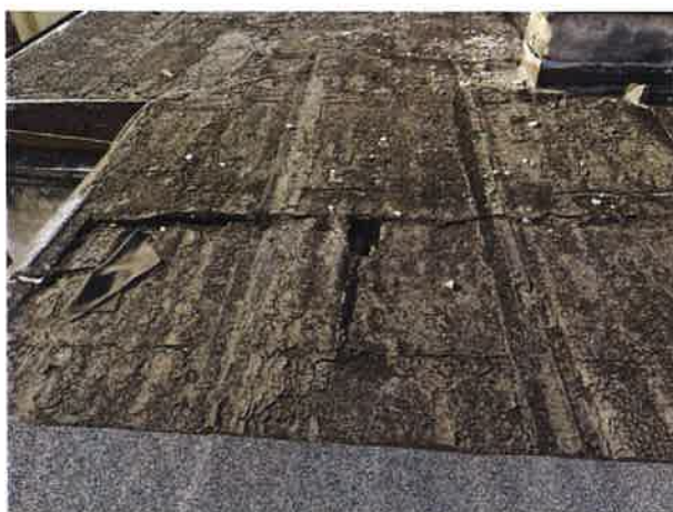
Zapadnięta konstrukcja dachu
