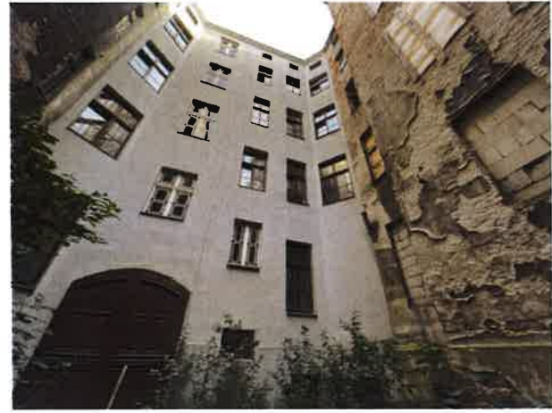
Zniszczenia ścian zewnętrznych
