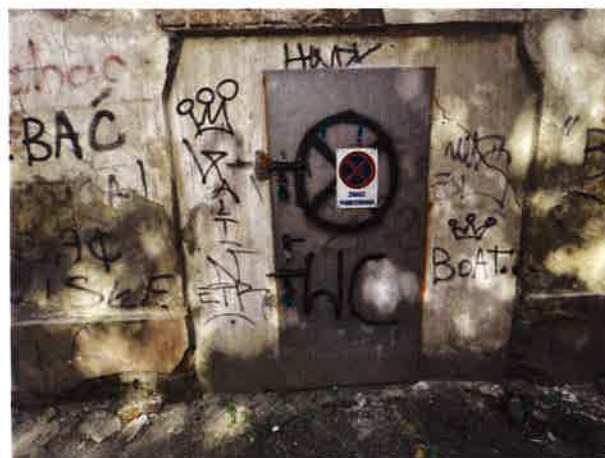
Braki dachówki na łączniku, brak rury spustowej
