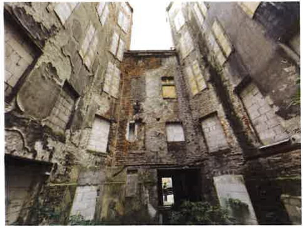
Zniszczenia ścian zewnętrznych
