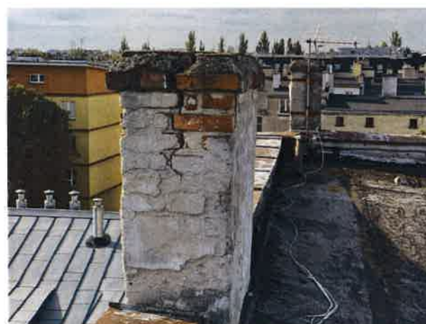
Spękany komin do rozebrania lub wzmocnienia PILNE
