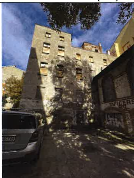
Zniszczenia ścian zewnętrznych
