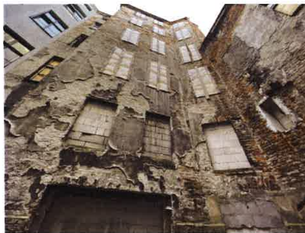
Zapadnięta konstrukcja dachu
